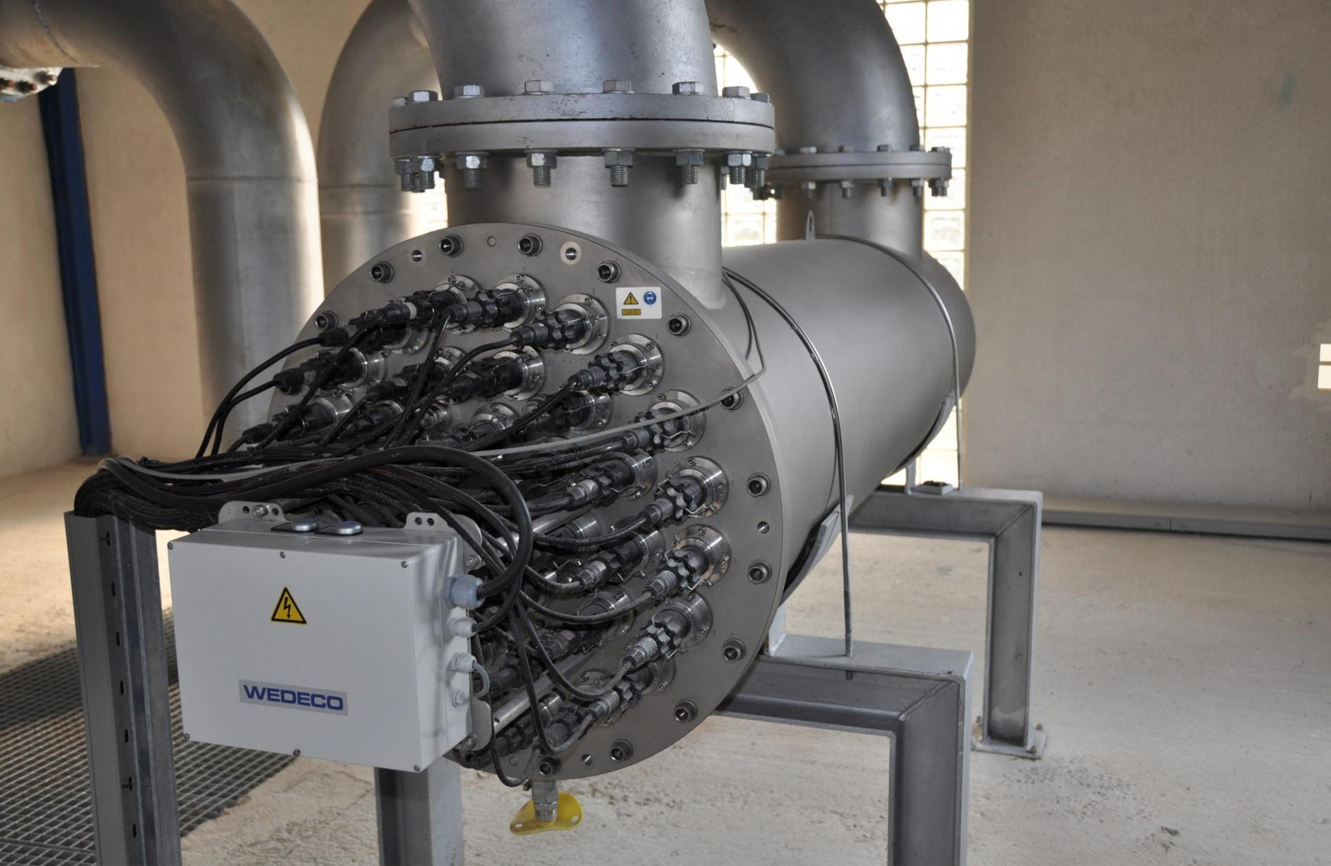
**DETALLE DE UN EQUIPO DE LÁMPARAS DE RAYOS ULTRAVIOLETA**
