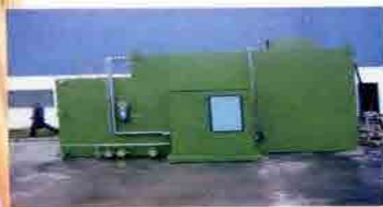
Imagen: Planta de tratamiento de aguas residuales STP
