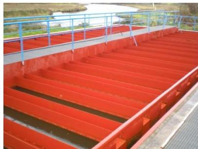
Para este proceso se dispone de un decantador rectangular. Este decantador es alimentado desde el canal principal, procedente directamente del canal de entrada a la ETAP.
