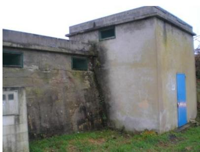
Depósito de cola situado a una cota de 95 m sobre el nivel del mar y con una capacidad de 300 m<sup>3</sup>, cuenta con dos vasos y actúa como depósito de cola, se abastece del depósito de Fazouro.
