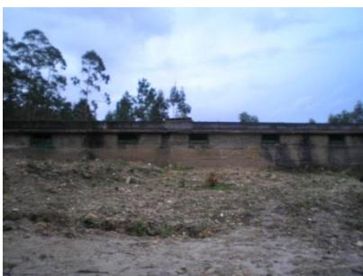
Es el Depósito de Cabecera, situado a una cota de 105 m sobre el nivel del mar y con una capacidad de 3.889 m<sup>3</sup>, cuenta con dos vasos, abastece a las poblaciones de Cangas, Nois, parte de Vilaronte y al núcleo poblacional del propio Foz. De este depósito se suministra agua a otros depósitos como son:
