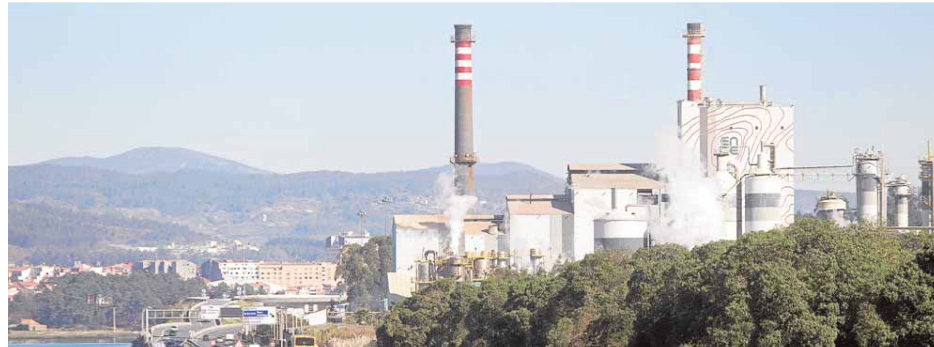
Centro de Operaciones de Ence en Pontevedra, líder europeo en fabricación de celulosa de eucalipto
